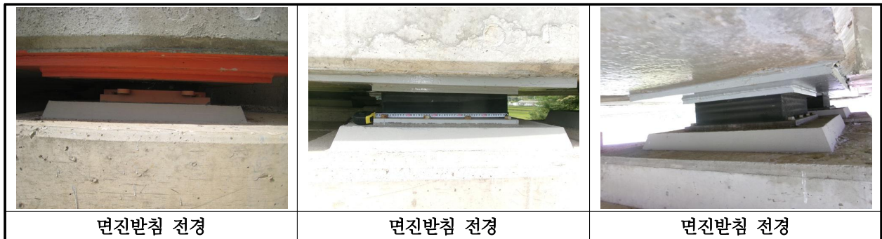
【사진 4.3.12】 교량받침 전경
