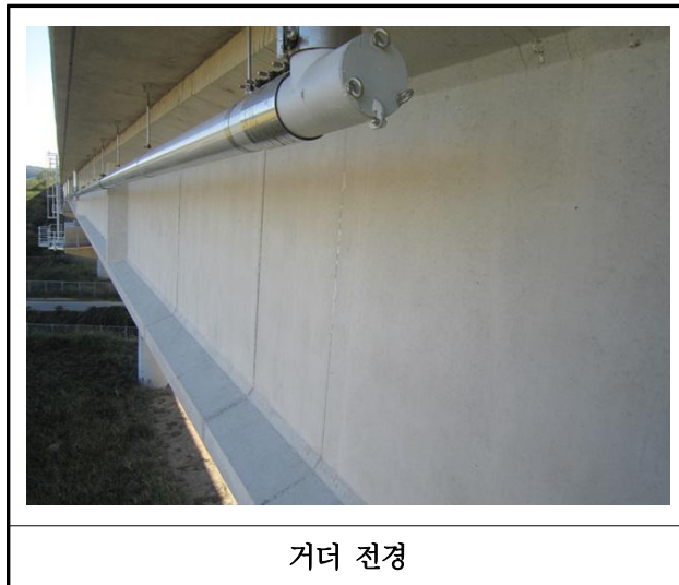
【사진 4.3.4】 거더 전경
