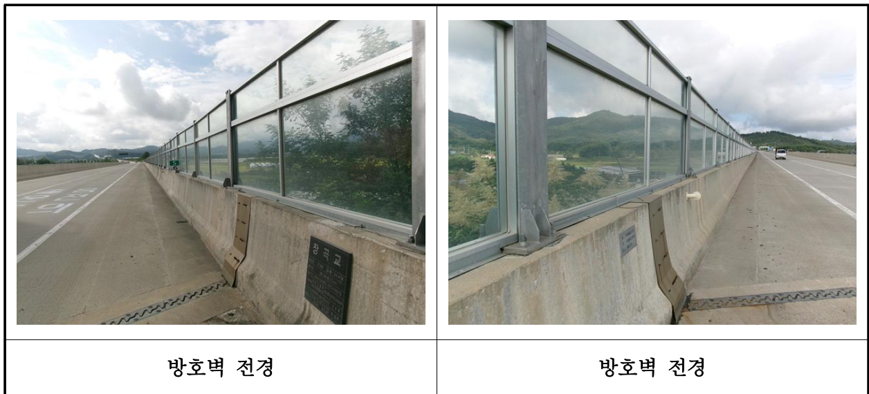
【사진 4.3.48】 방호벽 및 중앙분리대 전경
