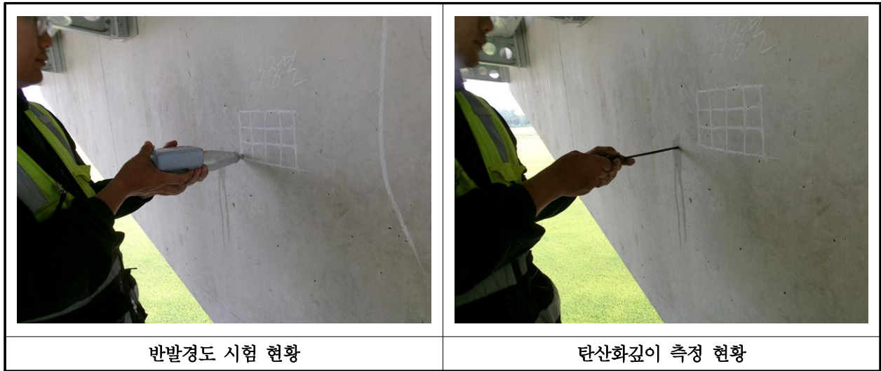
【사진 4.4.1】 콘크리트 내구성조사 현황
