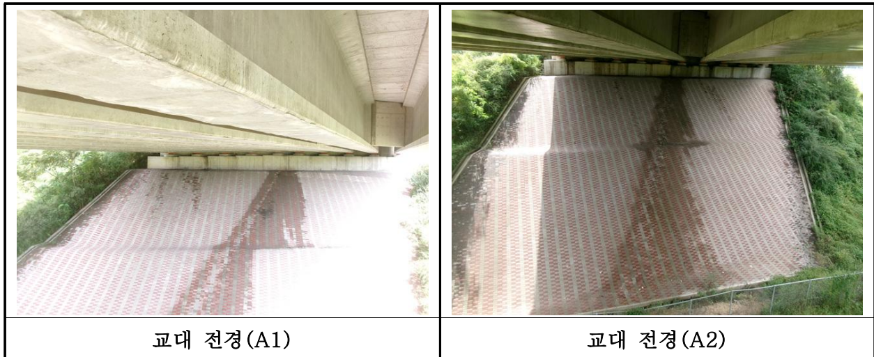
【사진 4.3.33】 교대 전경
