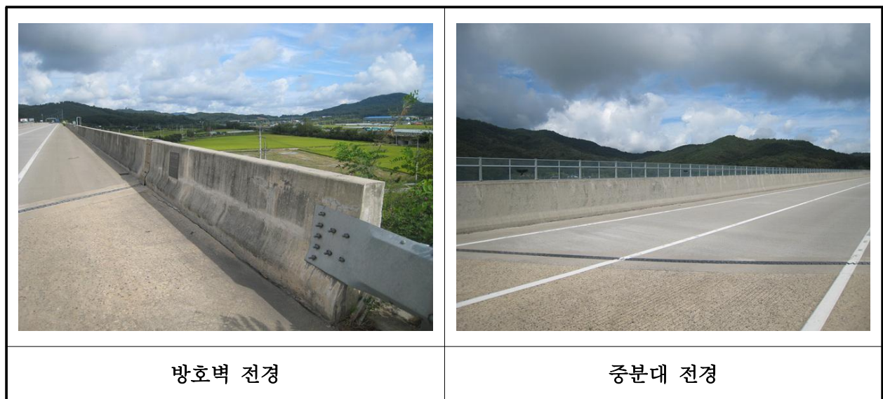
【사진 4.3.23】 방호벽 및 중앙분리대 전경
