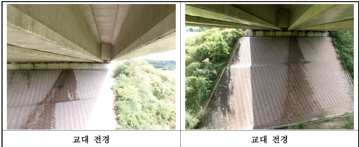
【사진 4.3.8】 교대 전경
