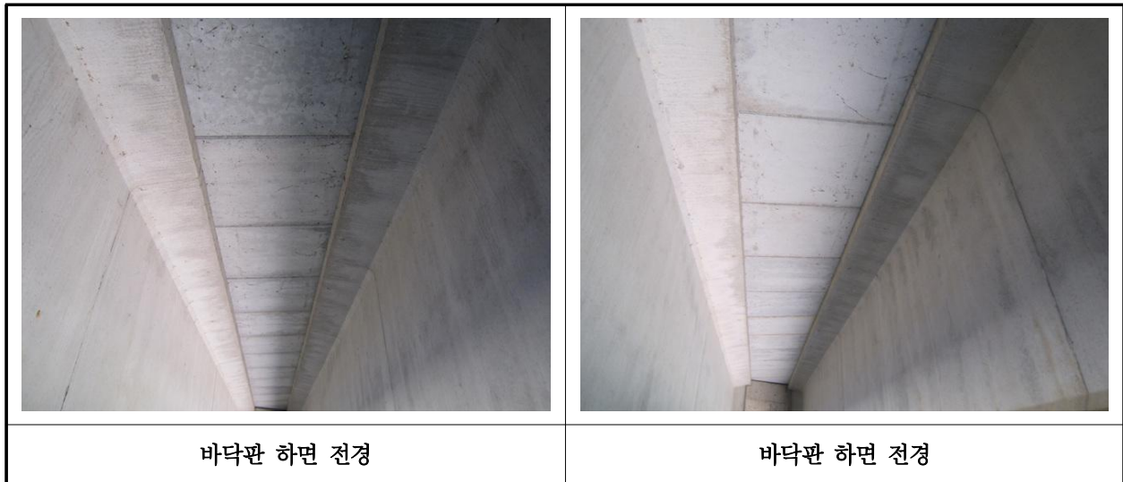
【사진 4.3.2】 바닥판하면 전경
