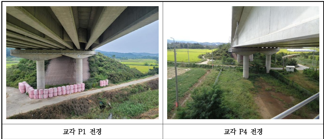
【사진 4.3.10】 교각 전경
