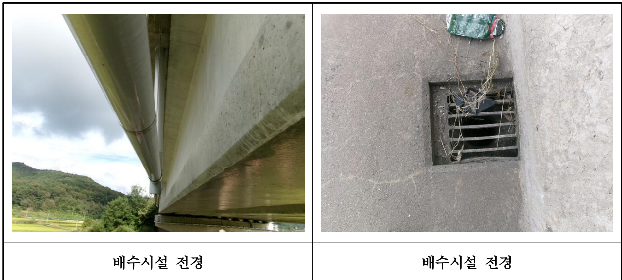
【사진 4.3.46】 배수시설 전경
