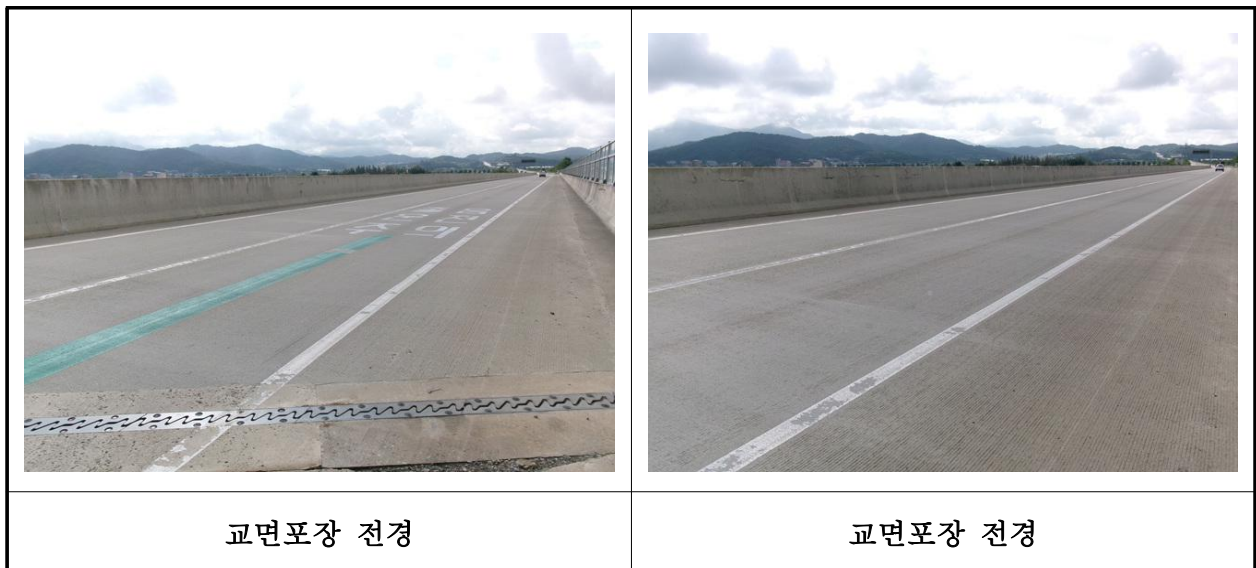
【사진 4.3.44】 교면포장 전경
