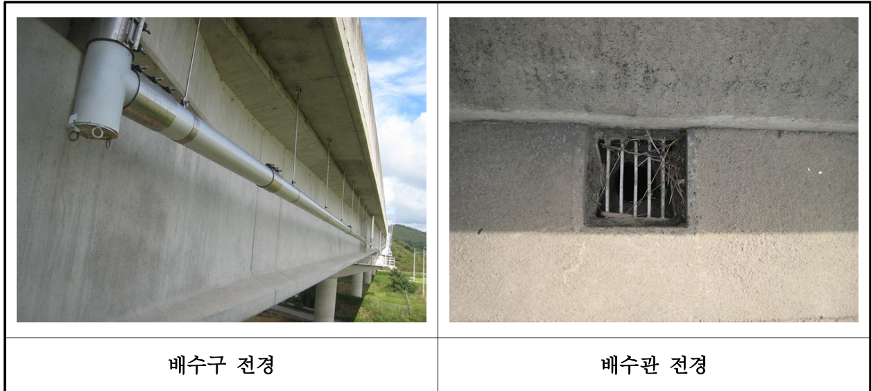
【사진 4.3.21】 배수시설 전경
