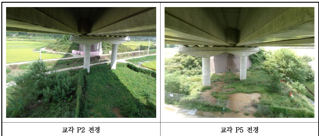
【사진 4.3.35】 교각 전경
