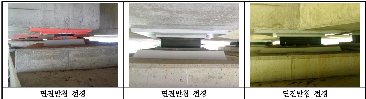
【사진 4.3.37】 교량반침 전경
